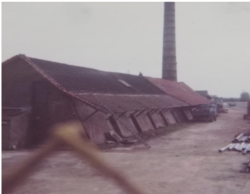
(41): de steenfabriek langs de Route de Furnes.
