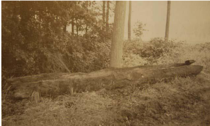
Uitgedisselde halve eiken boomstam in 1982 aangetroffen aan de Eikendreef in de omgeving van de hoeve Degruytere in Wingene (Deguffroy, 1982, p.5). Vermoedelijk was dit een onderdeel van een buis, die ingebed of ingegraven werd in één van de vijverdijken.
