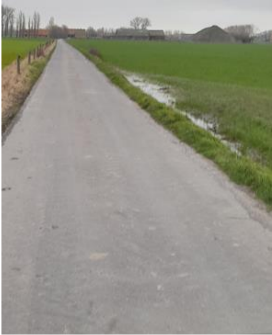
(65): de toegangsweg naar de hoeve
